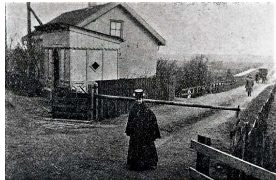
Spoorweg overgang met station 1890
